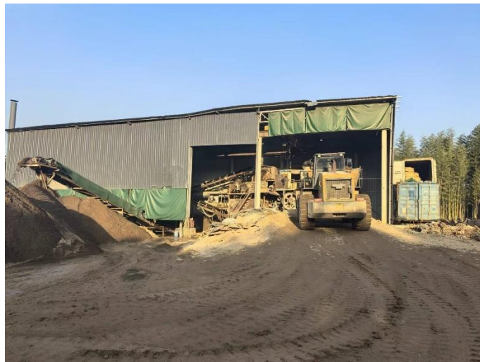
图 3.1-1 综合车间大门卷帘
