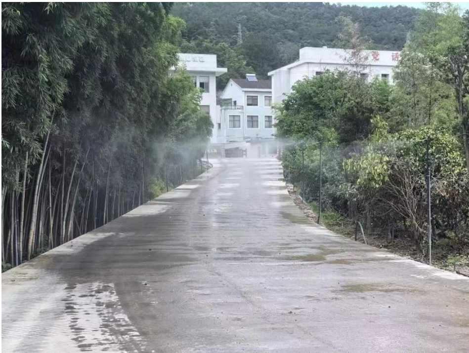
图 3.1-6 厂区入口道路硬化及喷雾装置
